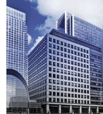
Kompleks biurowy Canary Wharf. Londyn.
